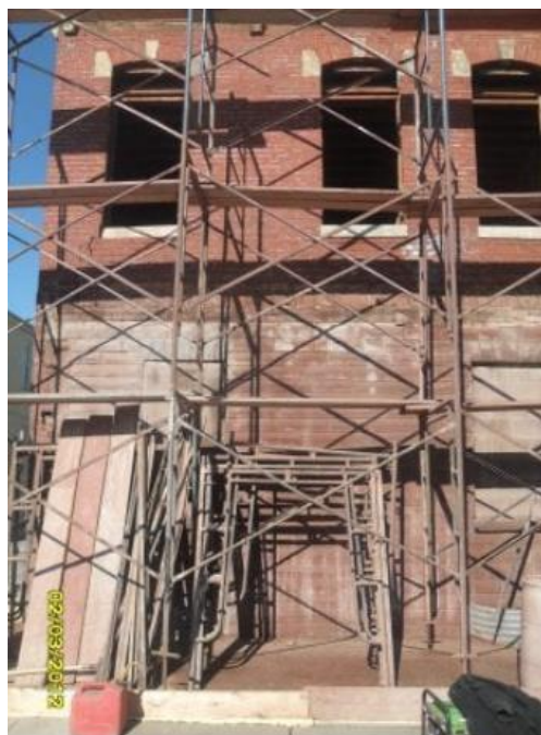
Ανακαίνιση εγκαταλελειμένου ακινήτου μέσω του προγράμματος V2V Πηγή: Shelterforce, 2018
