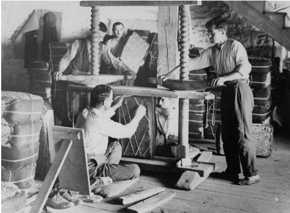
Εικ. 112. Κλασική επεξεργασία καπνών σε σαλόνη καπνομάγαζου στην Ξάνθη, στις αρχές του 20ού αι. Η διαδικασία της δεματοποίησης με την πρέσσα. (αρχείο Ι.Σιναμίδα)
