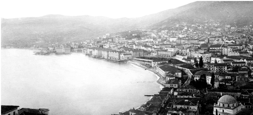
Εικ. 25 Πανοραμική άποψη του νοτιοδυτικού τμήματος της πόλης της Καβάλας στις αρχές του 20ού αι. (αρχείο Ι.Σιναμίδη)
